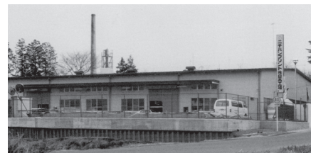
日高工場全景
