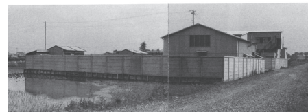
設立当時の本社工場全景
